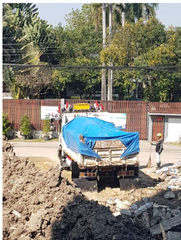
ภาพที่ 6-17 เก็บขนเศษวัสดุก่อสร้างใส่รถบรรทุกและปิดคลุมก่อนออกไปสู่ถนนสาธารณะ
