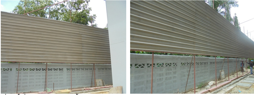
ภาพที่ 6-3 รื้อชั่วคราวความสูงต่อจากรั้วของบ้านของเคียง โดยรวมสูง 6 เมตร ป้องกันผลกระทบด้านฝุ่นละอองและเสียงดัง
