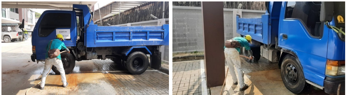
ภาพที่ 6-18 ล้างล้อรถขนส่งวัสดุก่อสร้างก่อนออกสู่ถนนสาธารณะภายนอกโครงการ
