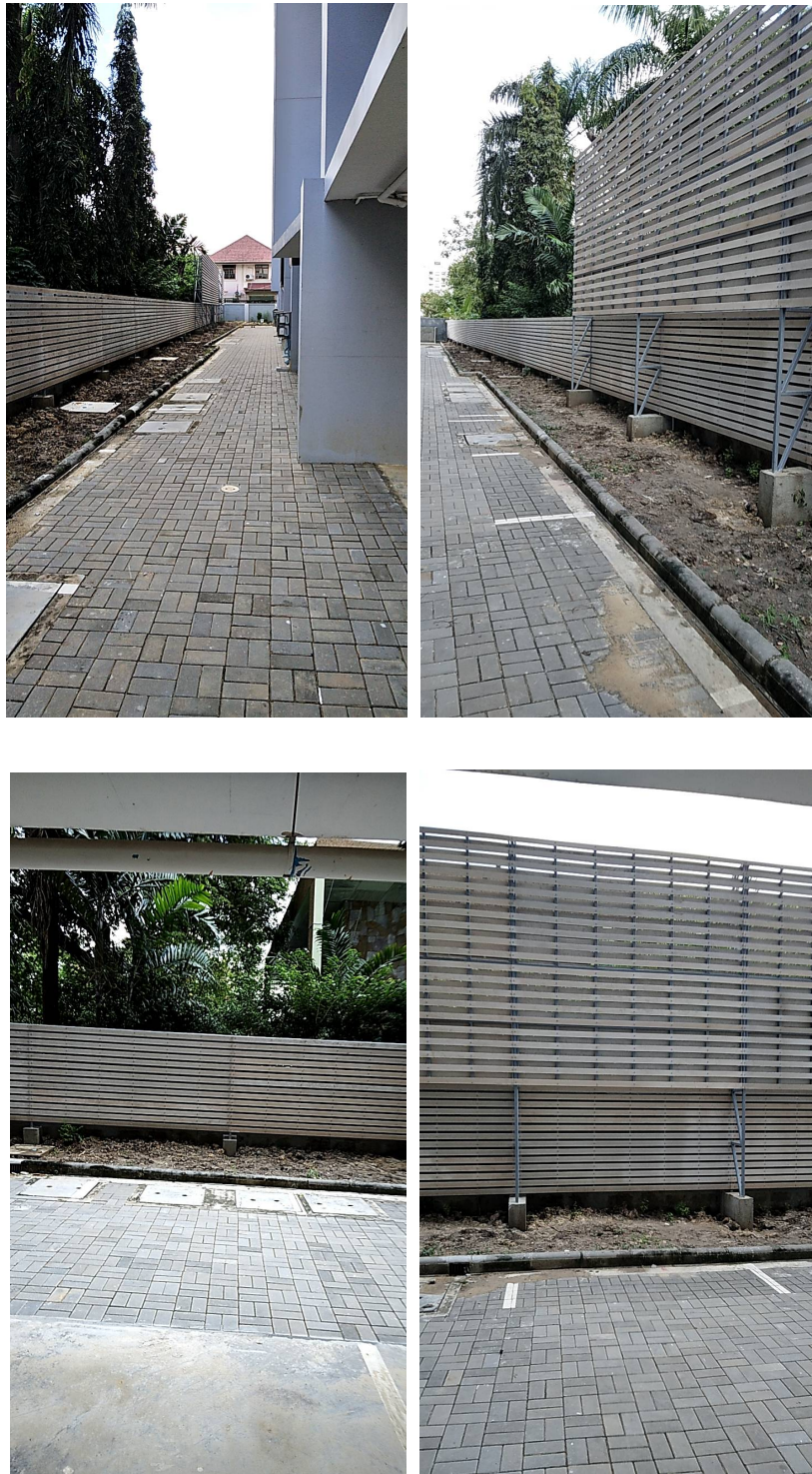
ภาพที่ 6-24 การก่อสร้างรั้วโครงการและระแนงเพื่อบดบังทัศนียภาพห้องพักชั้น2
