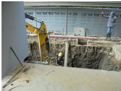
ภาพที่ 6-5 จัดให้มีระบบป้องกันดินพังในการขุดบ่อก่อสร้างระบบบำบัดน้ำเสีย
