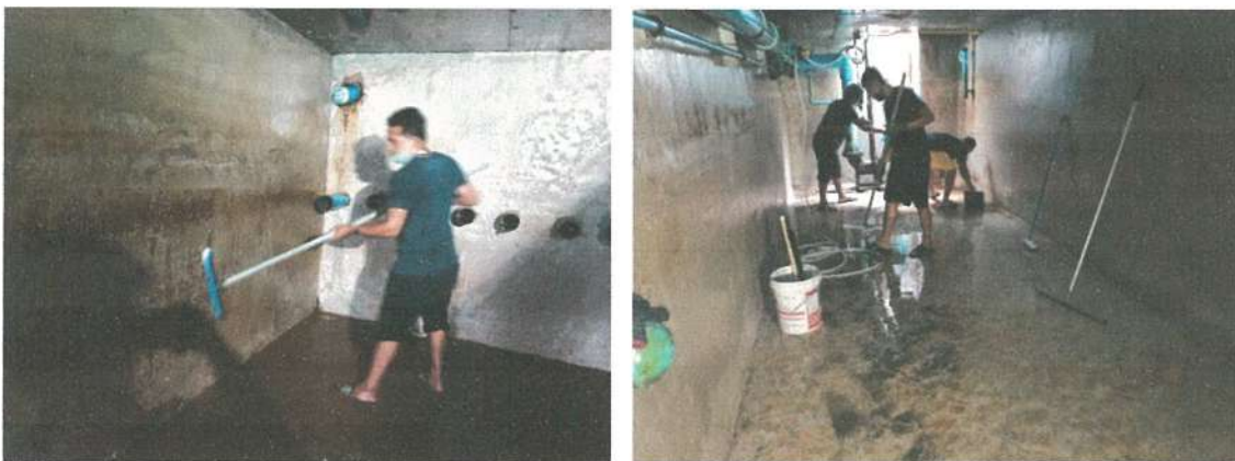
รูปภาพที่ 2.43 การล้างถังเก็บน้ำสำรอง
