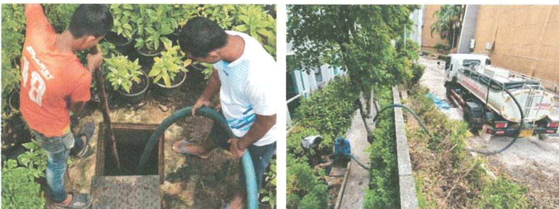
รูปภาพที่ 2.44 การสูบน้ำตะกอน
