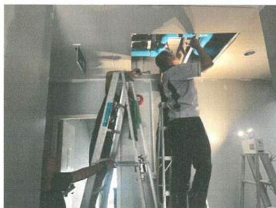
รูปภาพที่ 2.5 การตรวจเช็คเส้นท่อย้ายน้ำ
