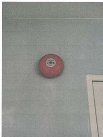
รูปภาพที่ 2.35 กริ่งสัญญาณเตือนภัย
