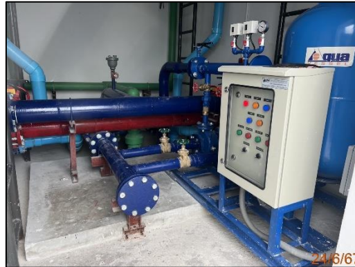
รูปที่ 17 ระบบสูบน้ำใช้
