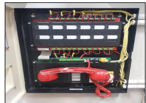
โทรศัพท์แจ้งเหตุฉุกเฉิน (Fire Telephone Outlet)
