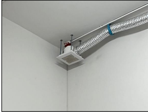
รูปที่ 14 พัดลมดูดอากาศ
