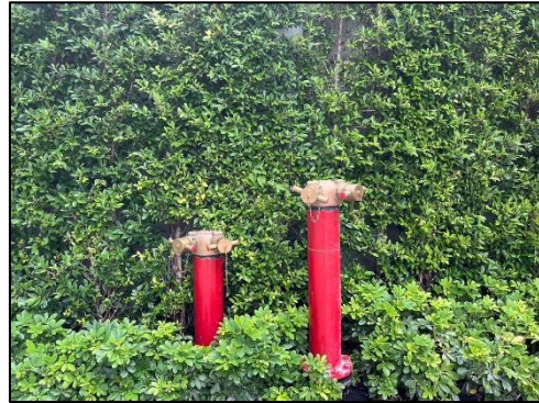
หัวรับน้ำดับเพลิงภายนอกอาคาร (อาคารจอดรถ)
