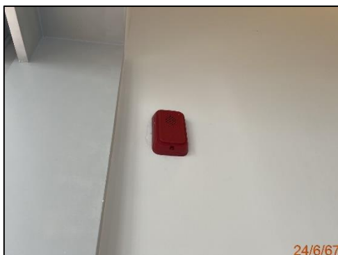
อุปกรณ์แจ้งเหตุเพลิงไหม้ด้วยเสียง (Fire Alarm Speaker)
