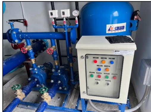
รูปที่ 23 บ่อหมุนวนน้ำและเครื่องสูบบ่อหมุนวนน้ำ
