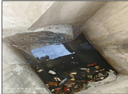
รูปที่ 11 บ่อพักน้ำสุดท้ายพร้อมตะแกรงดักขยะ
