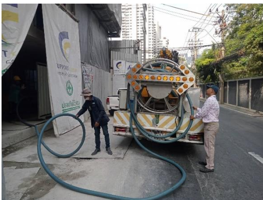
รูปที่ 48 การสูบน้ำในระบบบำบัดน้ำเสีย
