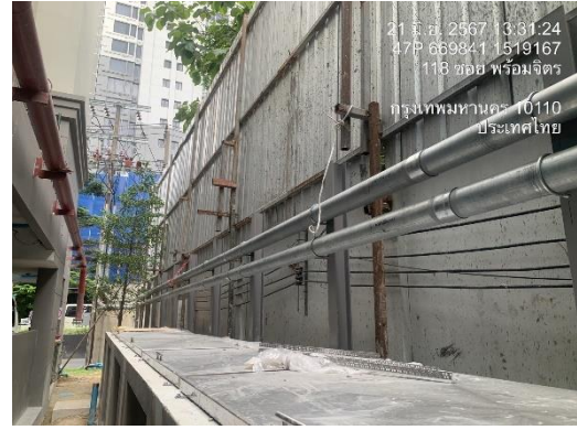
รูปที่ 3 รั้ว Metal Sheet สูง 6 เมตร
