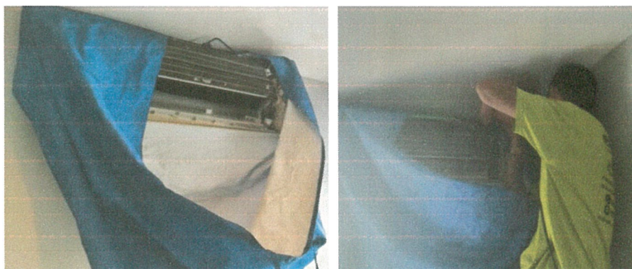
รูปภาพที่ 2.40 ล้างทำความสะอาดเครื่องปรับอากาศ
