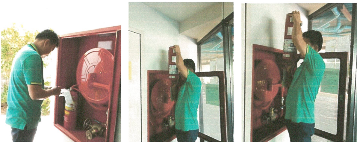
รูปภาพที่ 2.39 การตรวจสอบอุปกรณ์ป้องกันและระงับอัคคีภัย
