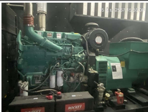
รูปที่ 9 แหล่งกำเนิดไฟฉุกเฉิน
