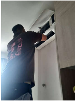
รูปที่ 4 เจ้าหน้าที่ทำความสะอาดเครื่องปรับอากาศ
