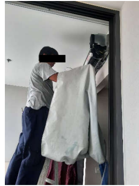
รูปที่ 4 เจ้าหน้าที่ทำความสะอาดเครื่องปรับอากาศ
