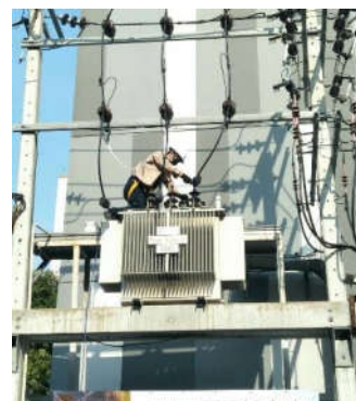
รูปที่ 38 ตรวจสอบหม้อแปลงไฟฟ้า
