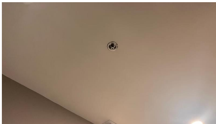
รูปที่ 19 ระบบหัวกระจายน้ำดับเพลิงอัตโนมัติ (Sprinkler System)
