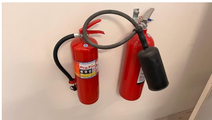
รูปที่ 20 ถังดับเพลิงมือถือชนิดคาร์บอนไดออกไซด์ (CO 2 )
