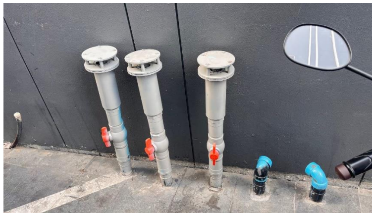
รูปที่ 7 ท่อเติมอากาศ (Aerosol)
