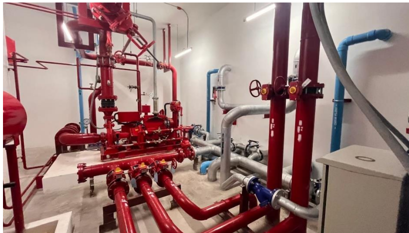
รูปที่ 16 เครื่องสูบน้ำดับเพลิง (Fire Pump)
