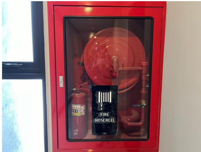
รูปที่ 18 ตู้เก็บสายฉีดน้ำดับเพลิงพร้อมอุปกรณ์ (Fire Hose Cabinet : FHC)
