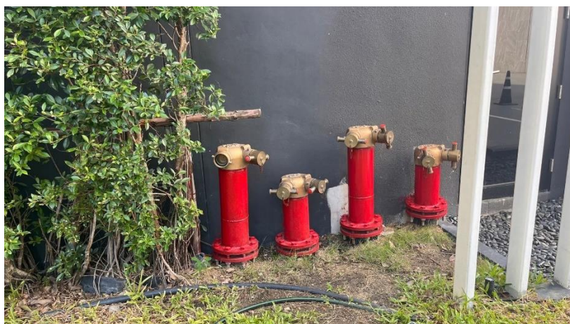
รูปที่ 17 หัวรับน้ำดับเพลิงภายนอกอาคาร (Fire Department Connector : FDC)
