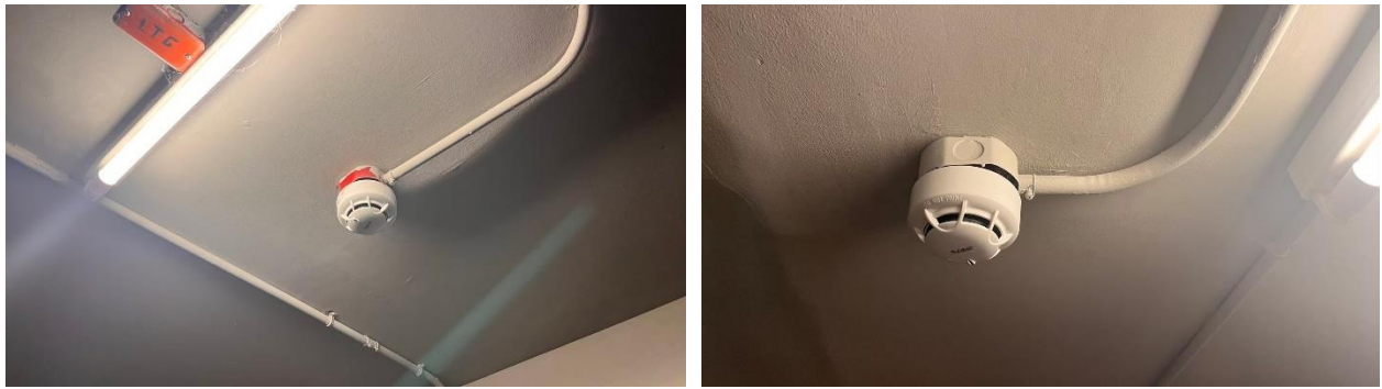
รูปที่ 15 อุปกรณ์ตรวจจับควัน (Smoke Detector)
