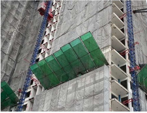
รูปที่ 33 ตะแกรงป้องกันวัสดุตกหล่น
