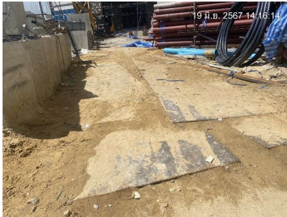
รูปที่ 17 แผ่นเหล็กปูพื้นโครงการ
