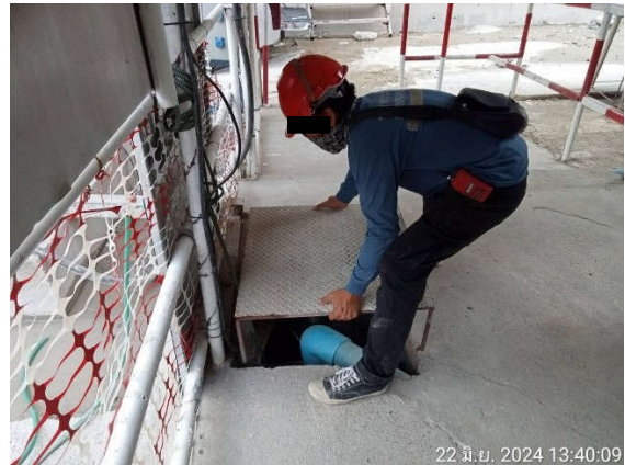
รูปที่ 10 เจ้าหน้าที่ตรวจสอบ รางระบายน้ำและปอดักตะกอน
