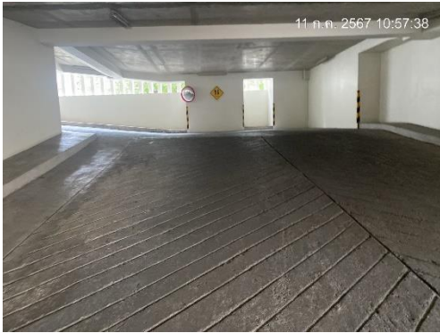
รูปที่ 7 ทำทางเท้าบริเวณทางเข้า-ออก ให้เหมาะสมกับรัศมีวงเลี้ยวของยานพาหนะ
