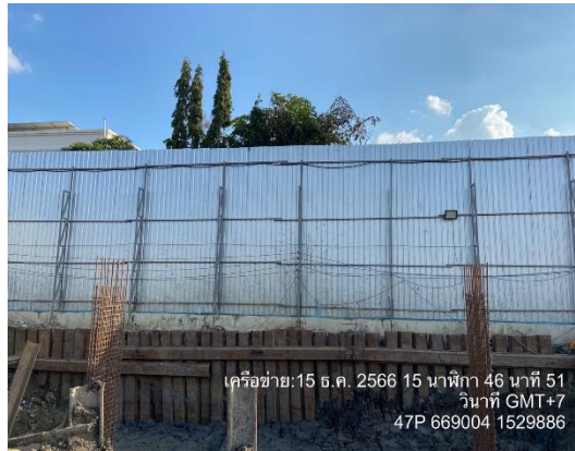
รูปที่ 14 Sheet Pile (ปัจจุบันทำการรื้อถอนเรียบร้อยแล้ว)
