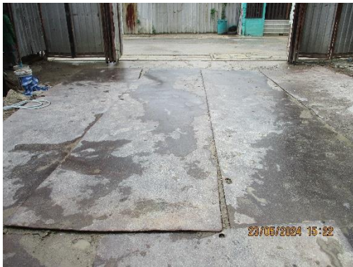
รูปที่ 10 ปูแผ่นเหล็ก
