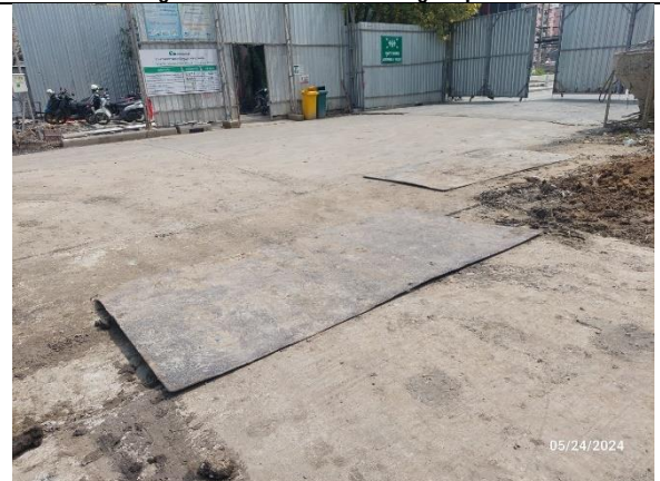
รูปที่ 2-37 แผ่นเหล็กปูพื้น
