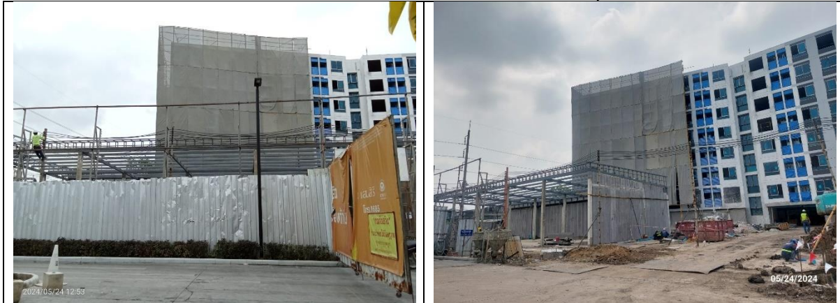
รูปที่ 2-7 ผ้าใบกันฝุ่น (Mesh Sheet)
