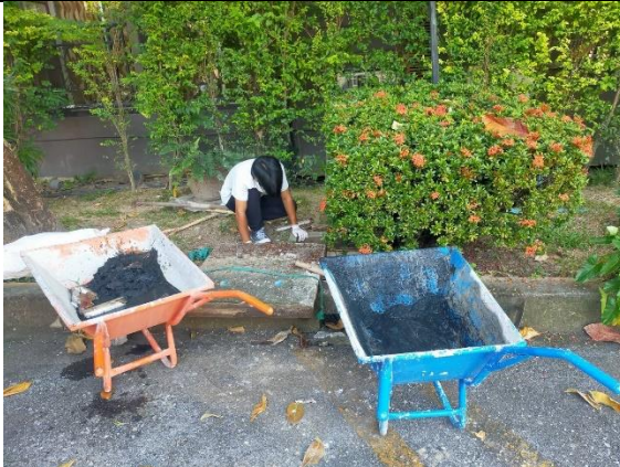
รูปที่ 2-20 การขุดลอก ทำความสะอาดระบบระบายน้ำ
