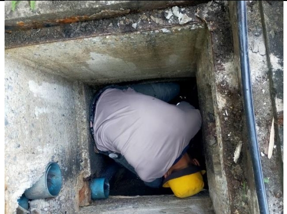
รูปที่ 2-20 การขุดลอก ทำความสะอาดระบบระบายน้ำ
