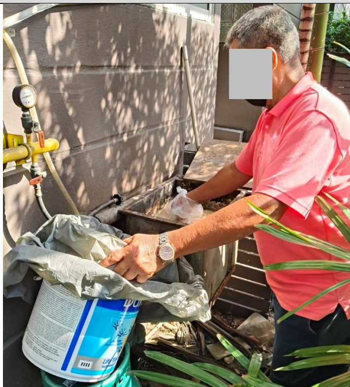
รูปที่ 2-6 การตัดไขมันจากบ่อดักไขมันเพื่อนำไปกำจัด
