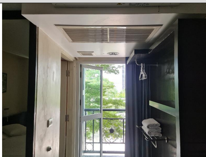
รูปที่ 2-26 การติดตั้งพัดลมระบายอากาศในห้องพักและในห้องน้ำ
