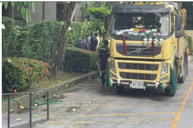
รูปที่ 2-7 การสูบกากตะกอนจากถังเกรอะของระบบบำบัดน้ำเสีย
