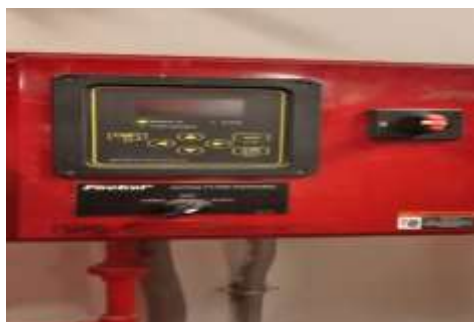
รูปที่ 2 ตรวจเช็คตู้คอนโทรล jockey pump
