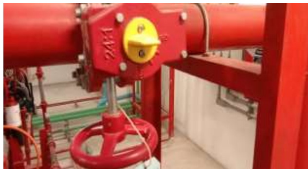
รูปที่ 15 ตรวจเช็ควาล์ว ปิด/เปิด น้ำ
