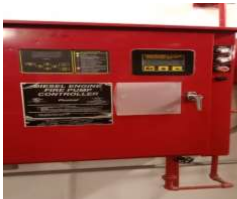
รูปที่ 1 ตรวจเช็คตู้คอลโทรลระบบปั้มแรงดันสูง
