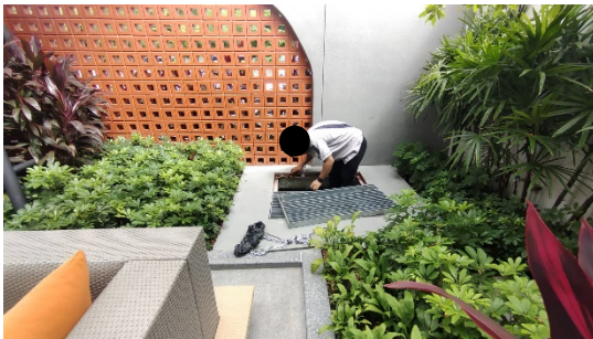
รูปที่ 13 เจ้าหน้าที่ตรวจสอบสิ่งอุดตันและตะแกรงดักขยะที่บ่อพักน้ำ
