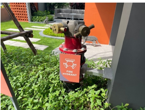
รูปที่ 37 ระบบแจ้งเตือนและอุปกรณ์ช่วยดับเพลิง
