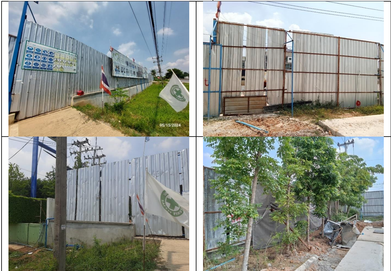
รูปที่ 2-1 รั้ว Metal sheet รอบพื้นที่โครงการพร้อมระบบค้ำยัน
