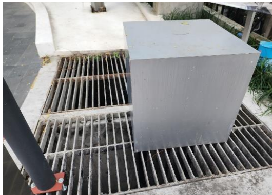
รูปที่ 46 ตะแกรงดักมูลฝอยที่บ่อพักน้ำสุดท้าย
