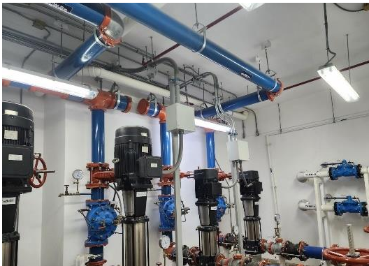
รูปที่ 20 ระบบสูบน้ำภายในโครงการและเจ้าหน้าที่ตรวจสอบ
