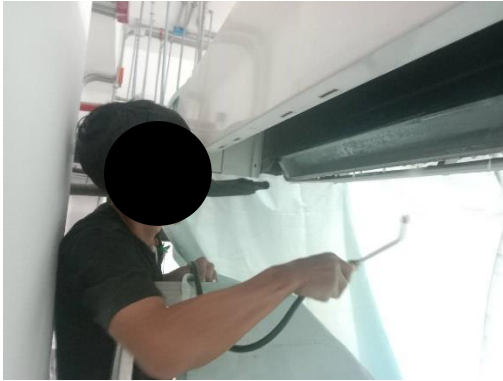
รูปที่ 45 เจ้าหน้าที่ล้างแผ่นกรองอากาศของเครื่องปรับอากาศ
