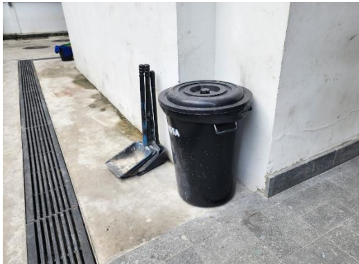
รูปที่ 23 รางระบายน้ำแบบมีฝาปิด
