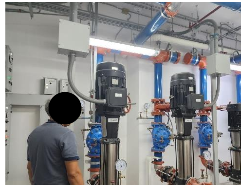
รูปที่ 20 ระบบสูบน้ำภายในโครงการและเจ้าหน้าที่ตรวจสอบ
