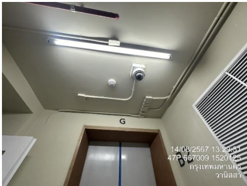
รูปที่ 8 กล้องวงจรปิด (CCTV) และระบบควบคุม
