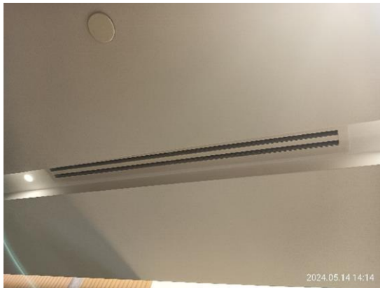
รูปที่ 3-5 ระบบระบายอากาศภายในอาคาร
