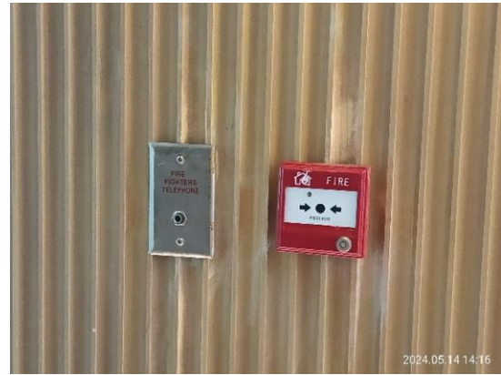
รูปที่ 3-60 ชุดกดแจ้งเหตุแบบใช้มือ
