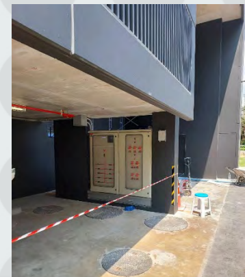
ตู้ไฟฟ้าควบคุมระบบบำบัดน้ำเสีย
