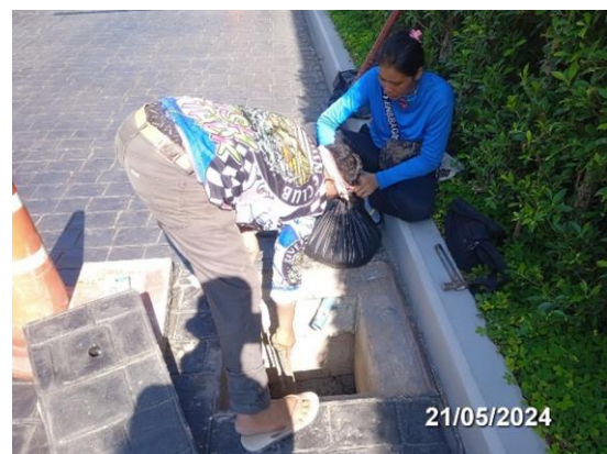
รูปที่ 3-40 พนักงานล้างทำความสะอาดท่อระบายน้ำ
