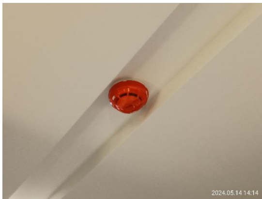
รูปที่ 3-61 เครื่องตรวจจับควัน และตรวจจับความร้อน
