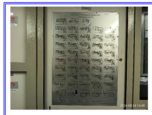
รูปที่ 3-58 แผงควบคุมระบบสัญญาณแจ้งเหตุ เพลิงไหม้
