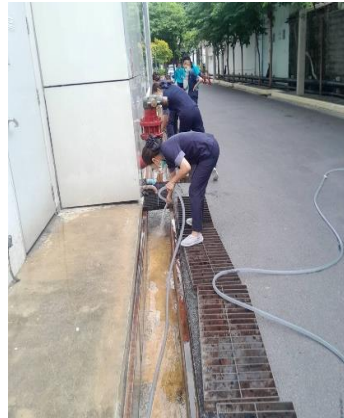
ภาพที่ 2.2-33 การขุดลอกท่อระบายน้ำ
