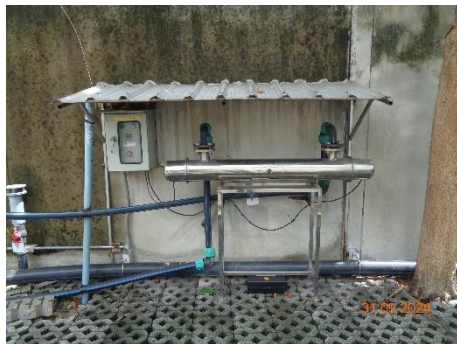
ภาพที่ 2.2-17 ระบบฆ่าเชื้อโรคในน้ำทั้งด้วยวิธี UV
