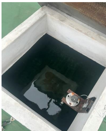
ภาพที่ 2.2-44 การสำรองน้ำสำหรับดับเพลิง
