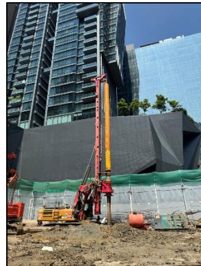
ภาพที่ 21 ก่อสร้างฐานรากโดยใช้เสาเข็มเจาะ
