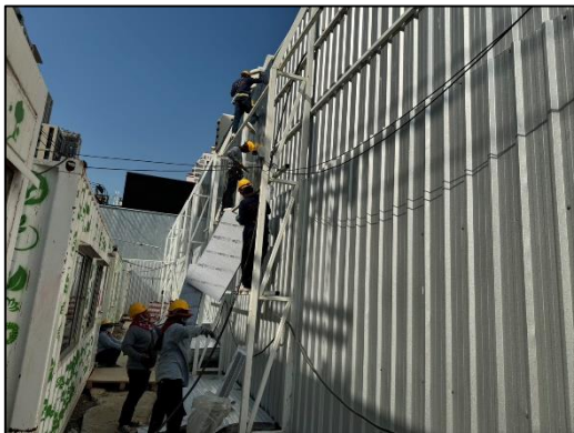
ภาพที่ 6 รั้ว Metal Sheet กรงด้วยฉนวนกันเสียง Isonoise
