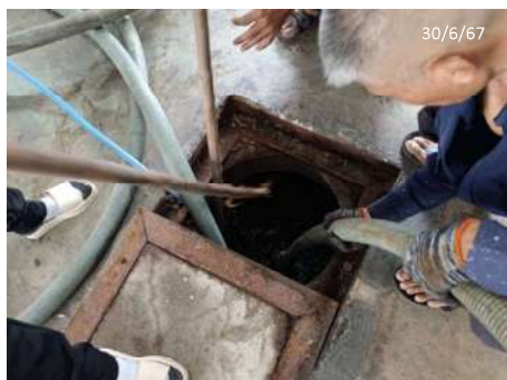
ภาพที่ 2.2-8 การทำความสะอาดถังพักไขมันและการสูบล้างถัง
