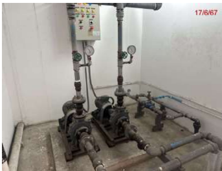
ภาพที่ 2.2-10 ระบบสูบน้ำประปาและวาล์วควบคุมการจ่ายน้ำ
