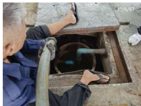
ภาพที่ 2.2-8 การทำความสะอาดถังพักไขมันและการสูบล้างถัง
