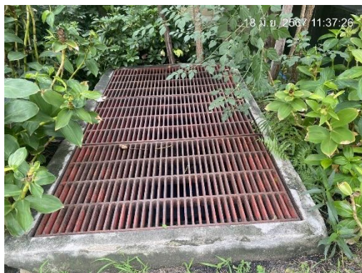
รูปที่ 11 ตะแกรงดักขยะ
