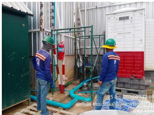
รูปที่ 18 ดูแลระบบบำบัดน้ำเสีย
