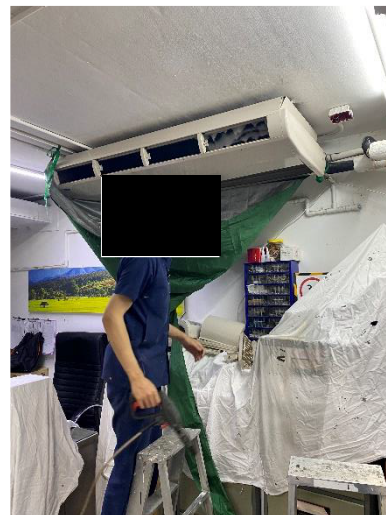
รูปที่ 15 เจ้าหน้าที่ทำความสะอาดเครื่องปรับอากาศ
