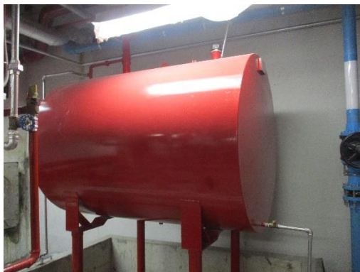
รูปที่ 82 ถึงสำรองน้ำดับเพลิง
