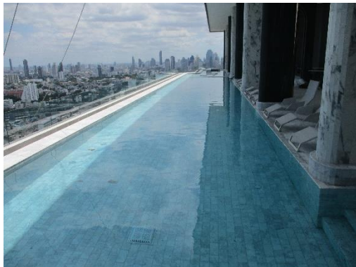
รูปที่ 82 ถึงสำรองน้ำดับเพลิง
