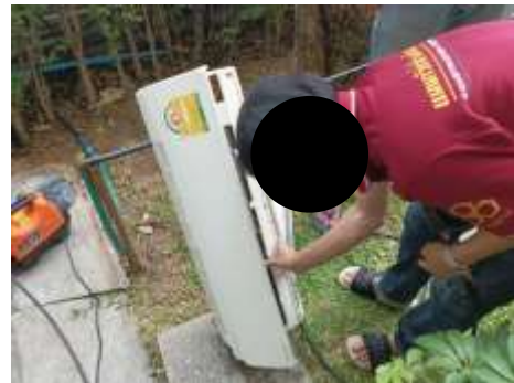
รูปที่ 14 ทำความสะอาดเครื่องปรับอากาศ
