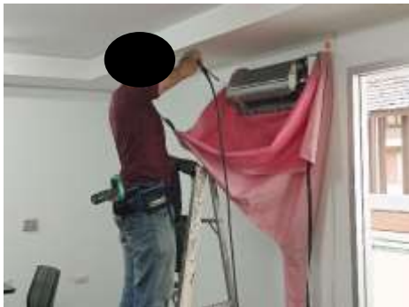
รูปที่ 14 ทำความสะอาดเครื่องปรับอากาศ
