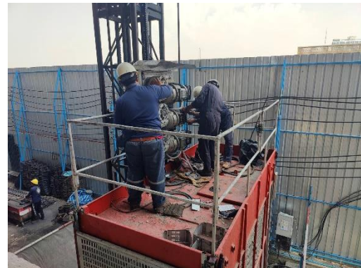
รูปที่ 31 หยอดน้ำมันหล่อลื่น
