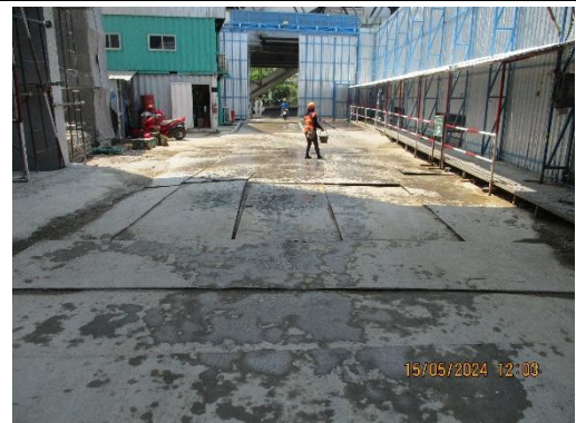
รูปที่ 23 ปูแผ่นเหล็กด้านหน้าโครงการ
