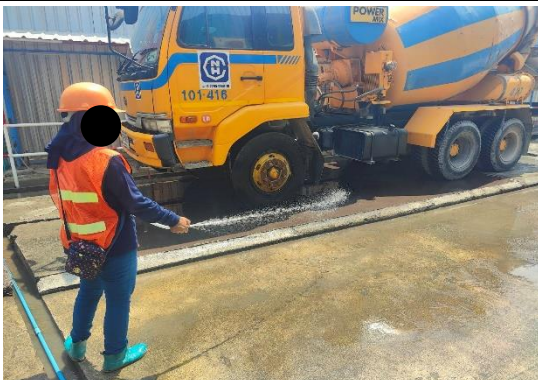
รูปที่ 22 เจ้าหน้าที่ล้างล้อรถก่อนออกจากโครงการ
