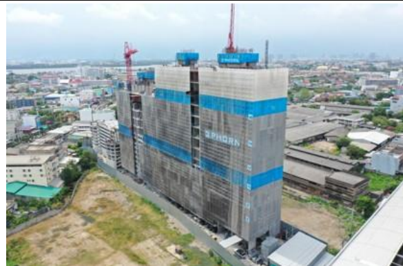
รูปที่ 11 ติดตั้งผ้าใบก่อสร้าง (Mesh sheet) ตลอดความสูงอาคาร
