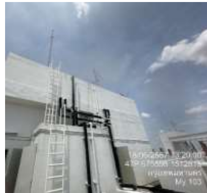
รูปที่ 7 ถังเก็บน้ำาดาดฟ้า
