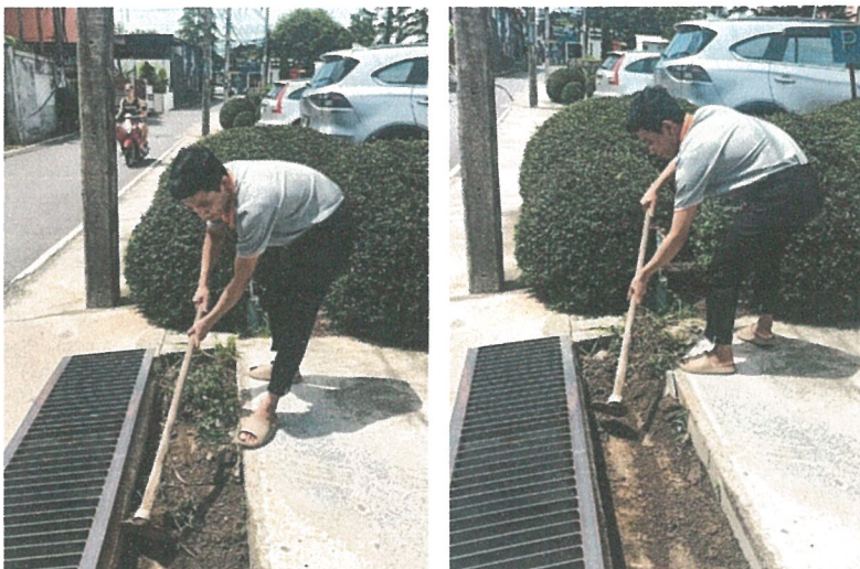
รูปภาพที่ 2.32 การขุดลอกตะกอน
