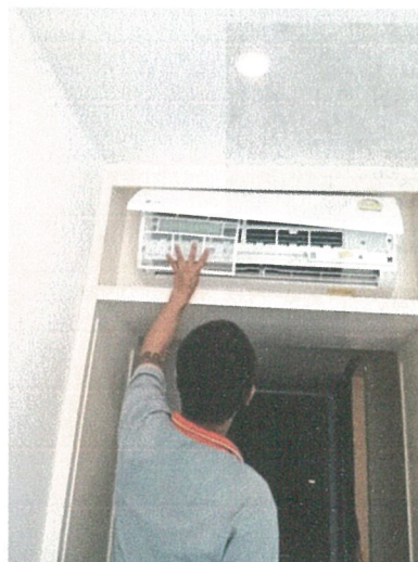
รูปภาพที่ 2.25 ถ้างทำความสะอาดแผ่นกรองอากาศ
