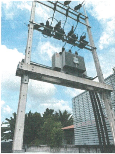
รูปภาพที่ 2.13 หม้อแปลงไฟฟ้า
