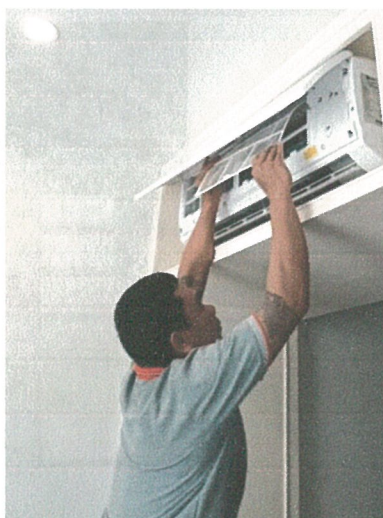
รูปภาพที่ 2.25 ถ้างทำความสะอาดแผ่นกรองอากาศ
