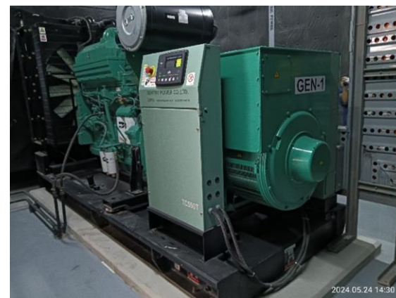
รูปที่ 2.5-13 เครื่องกำเนิดไฟฟ้าสำรอง
