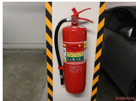
รูปที่ 3-10 ถังดับเพลิงเคมีแบบมือถือ
