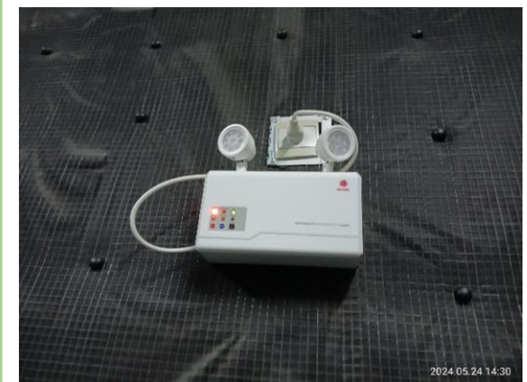
รูปที่ 2.5-14 ไฟส่องสว่างฉุกเฉิน
