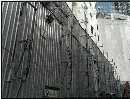
รูปที่ 3-1 รั้วทึบชั่วคราว Metal Sheet สูง 6 เมตร และม่านกัน บริเวณทางเข้า-ออก
