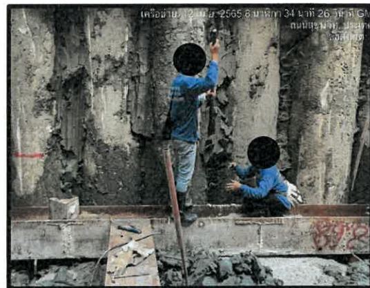
รูปที่ 3-19 ระบบป้องกันดินพังของโครงการ
