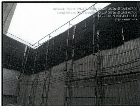
รูปที่ 3-8 สเปรย์น้ำดับฝุ่นละอองบริเวณรั้วของโครงการ
