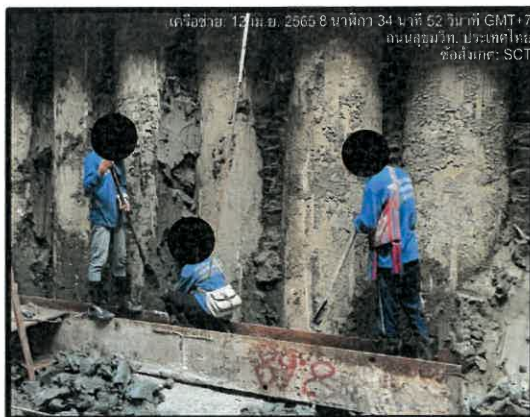
รูปที่ 3-19 ระบบป้องกันดินพังของโครงการ
