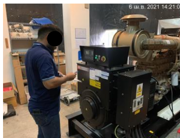
รูปที่ 2-14 เจ้าหน้าที่ตรวจสอบเครื่องกำเนิดไฟฟ้าสำรอง
