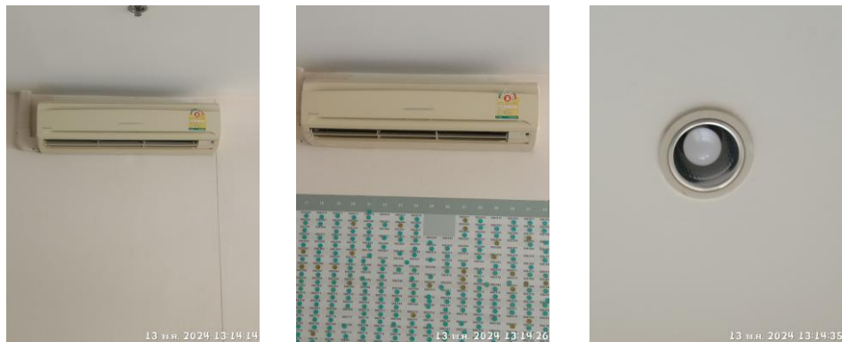
รูปที่ 2-21 อุปกรณ์ประหยัดไฟเบอร์ 5 และหลอดไฟประหยัดไฟ
