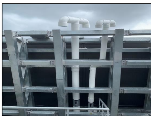
รูปที่ 29 ท่อระบายอากาศออกภายนอกอาคาร
