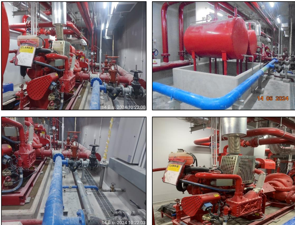
รูปที่ 38 เครื่องสูบน้ำดับเพลิงภายในพื้นที่โครงการ
