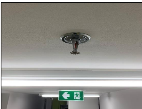
รูปที่ 44 หัวกระจายน้ำดับเพลิงอัตโนมัติ
