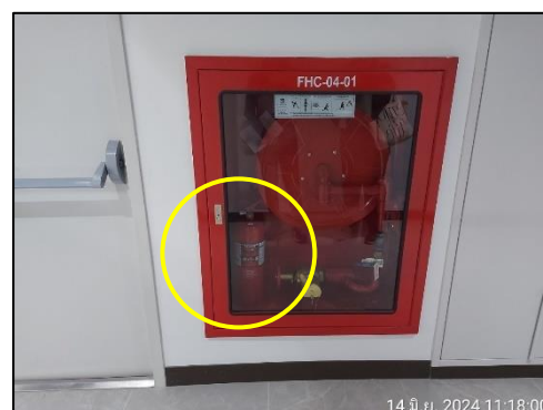
รูปที่ 43 ถังดับเพลิงชนิดผงเคมีแห้งภายในพื้นที่โครงการ
