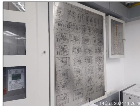
รูปที่ 54 แผงควบคุมระบบเตือนอัคคีภัย
