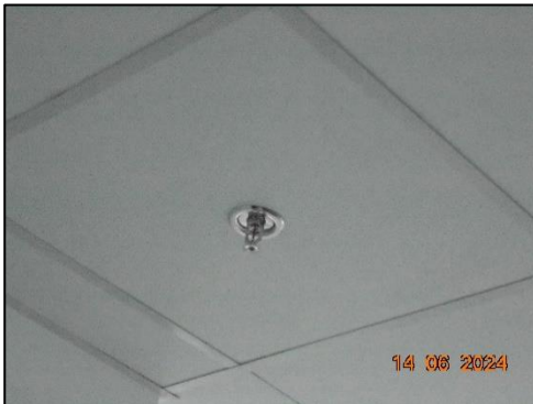
รูปที่ 69 หัวกระจายน้ำดับเพลิงภายในห้องครัว
