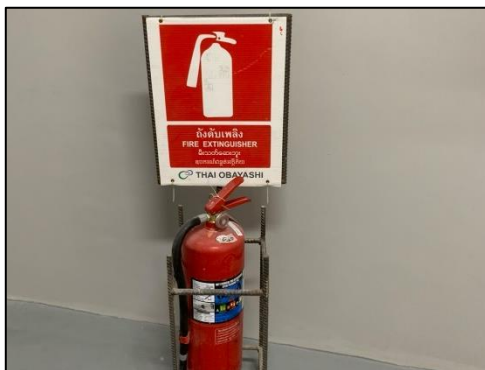
รูปที่ 43 ถังดับเพลิงชนิดผงเคมีแห้งภายในพื้นที่โครงการ
