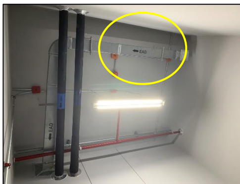
รูปที่ 28 ท่อระบายอากาศห้องขยะ
