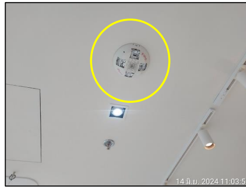
รูปที่ 53 กรังสัญญาณเตือนภัย
