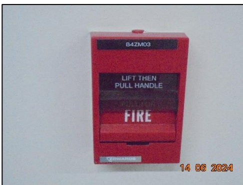
รูปที่ 52 เครื่องเตือนเพลิงไหม้
