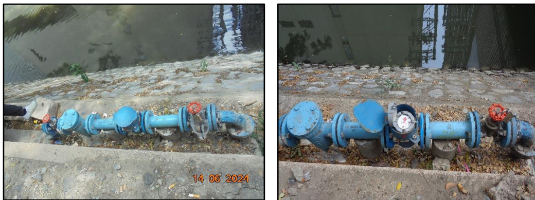
รูปที่ 1-4 จุดเชื่อมต่อท่อน้ำประปาเข้าพื้นที่โครงการ
