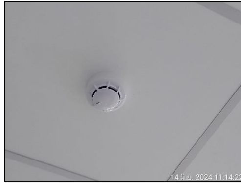
รูปที่ 49 เครื่องตรวจจับควัน
