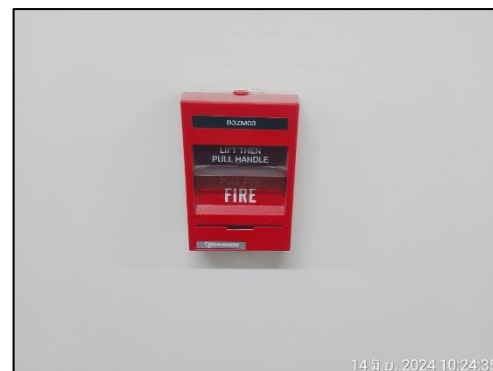
รูปที่ 52 เครื่องเตือนเพลิงไหม้
