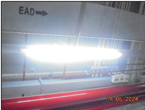
รูปที่ 32 วัสดุกันเสียงห้องเครื่องกำเนิดไฟฟ้า
