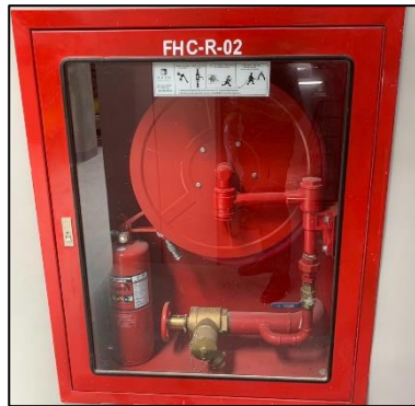
รูปที่ 41 สายฉีดน้ำดับเพลิงพร้อมอุปกรณ์ดับเพลิง
