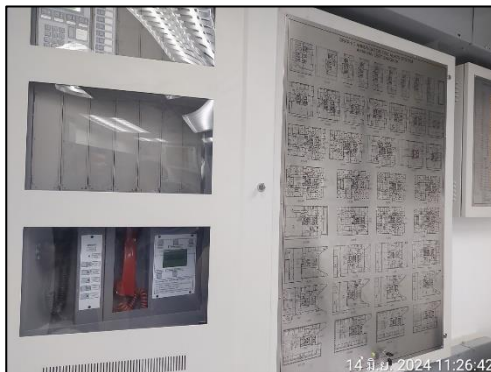
รูปที่ 54 แผงควบคุมระบบเตือนอัคคีภัย
