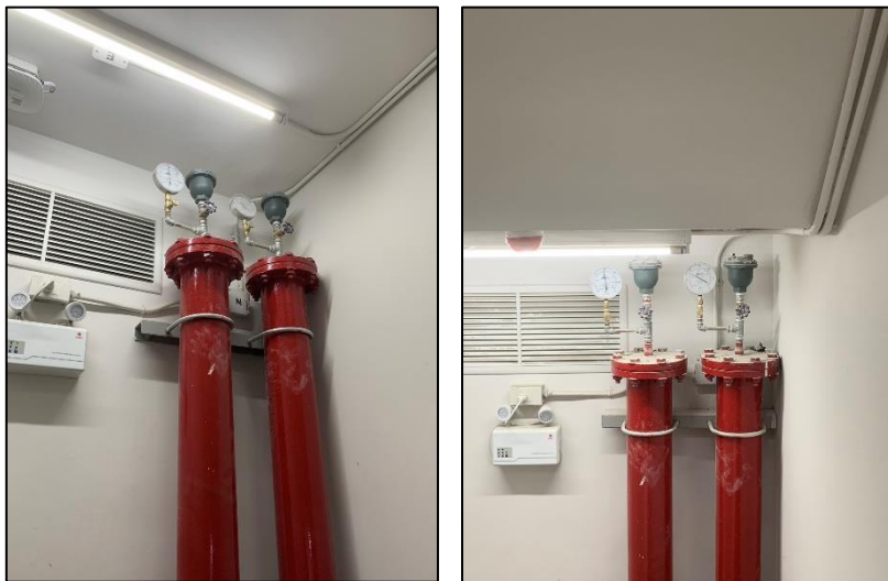
รูปที่ 39 ระบบท่อยืนน้ำดับเพลิงภายในพื้นที่โครงการ
