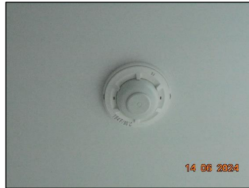
รูปที่ 50 อุปกรณ์ตรวจวัดความร้อน
