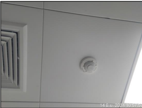
รูปที่ 50 อุปกรณ์ตรวจวัดความร้อน
