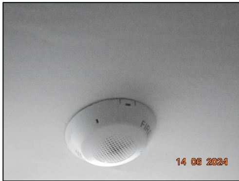
รูปที่ 53 กรังสัญญาณเตือนภัย
