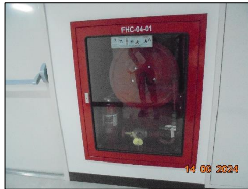
รูปที่ 41 สายฉีดน้ำดับเพลิงพร้อมอุปกรณ์ดับเพลิง
