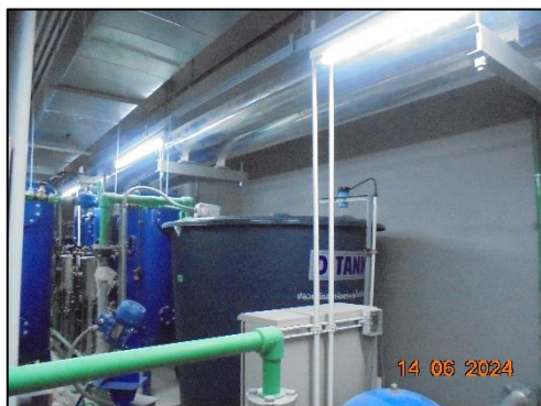
รูปที่ 12 ถังสำรองน้ำชั้นหลังคา
