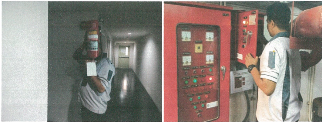
รูปภาพที่ 2.19 การตรวจสอบระบบป้องกันและแจ้งเตือนอัคคีภัย
