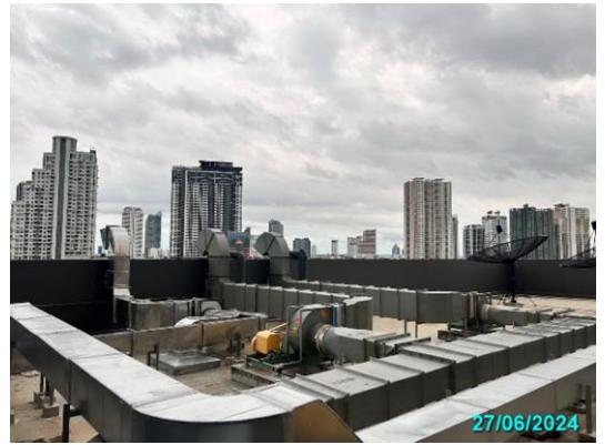
รูปที่ 3-31 ท่อระบายก๊าซมีเทน
