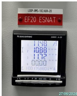
รูปที่ 3-20 มาตรวัดไฟฟ้าของระบบบำบัดน้ำเสีย
