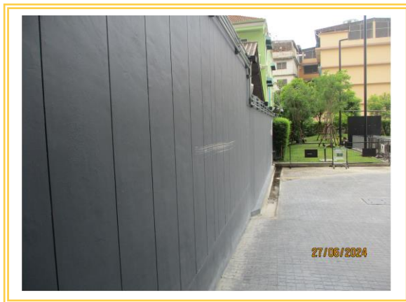
รูปที่ 3-5 กำแพงคอนกรีตหนา 0.15 เมตร รอบโครงการ
