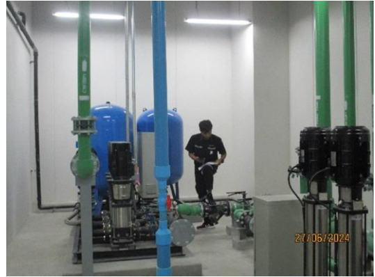
รูปที่ 3-16 เจ้าหน้าที่ตรวจสอบการรั่วไหลของน้ำและ ระบบเส้นท่อประปาของโครงการ
