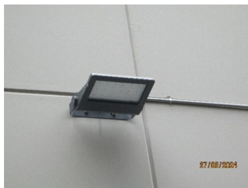
รูปที่ 3-36 หลอดไฟฟ้าแบบ LED
