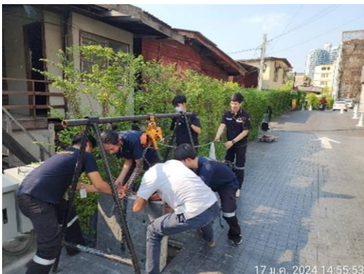
รูปที่ 3-22 ขุดลอกท่อระบายน้ำ
