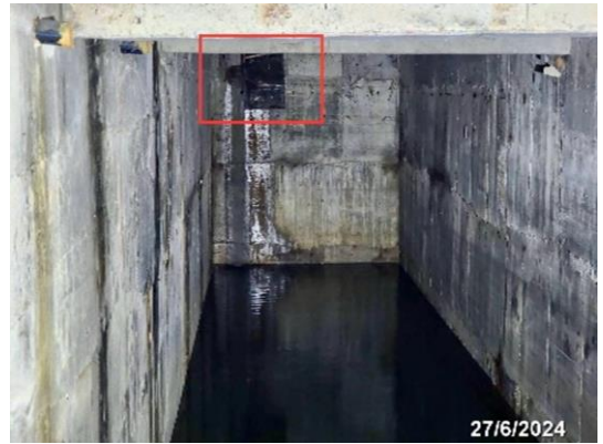
รูปที่ 3-21 ตะแกรงดักมูลฝอยบริเวณจุดระบายน้ำก่อนเข้าสู่ท่อระบายน้ำ
