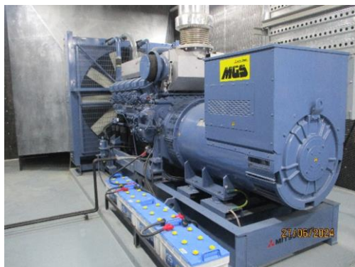
รูปที่ 3-35 เครื่องกำเนิดไฟฟ้าสำรอง
