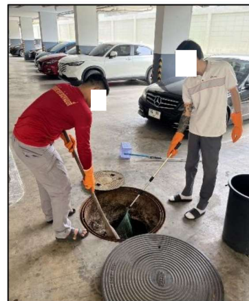
รูปที่ 27 ตรวจสอบและดูแลบ่อดักไขมันอย่างต่อเนื่อง
