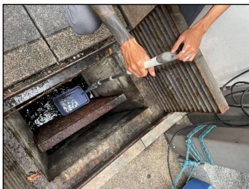
รูปที่ 29 ทำความสะอาดสิ่งอุดตันบริเวณบ่อหน่วงน้ำและบ่อพักน้ำ
