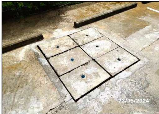
รูปที่ 28 บ่อหน่วงน้ำฝนบริเวณพื้นที่โครงการ
