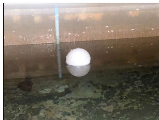
รูปที่ 16 ระบบลูกลอยในถังเก็บน้ำสำรอง
