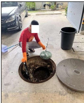
รูปที่ 27 ตรวจสอบและดูแลบ่อดักไขมันอย่างต่อเนื่อง
