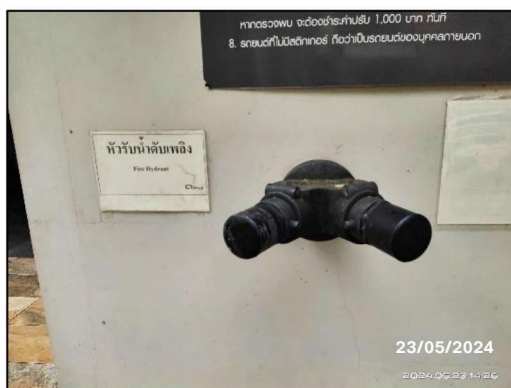
รูปที่ 36 ติดตั้งหัวรับน้ำดับเพลิงด้านหน้าโครงการ
