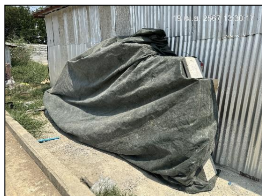
ภาพที่ 7 พื้นที่เก็บกองวัสดุก่อสร้างมีผ้าใบปิดคลุม
