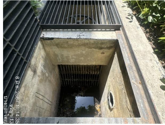
รูปที่ 3-21 ติดตั้งตะแกรงดักขยะ
