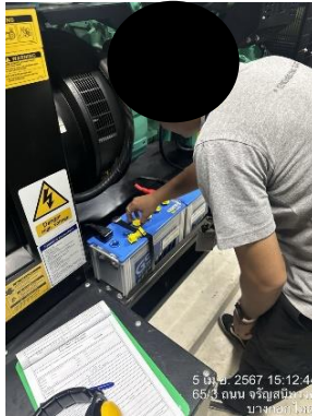
รูปที่ 3-30 เจ้าหน้าที่ตรวจสอบเครื่องกำเนิดไฟฟ้าสำรอง
