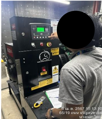
รูปที่ 3-30 เจ้าหน้าที่ตรวจสอบเครื่องกำเนิดไฟฟ้าสำรอง
