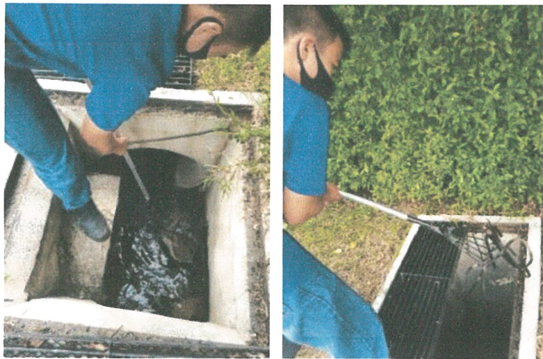
รูปภาพที่ 2.35 การขุดลอกตะกอนในรางระบายน้ำ
