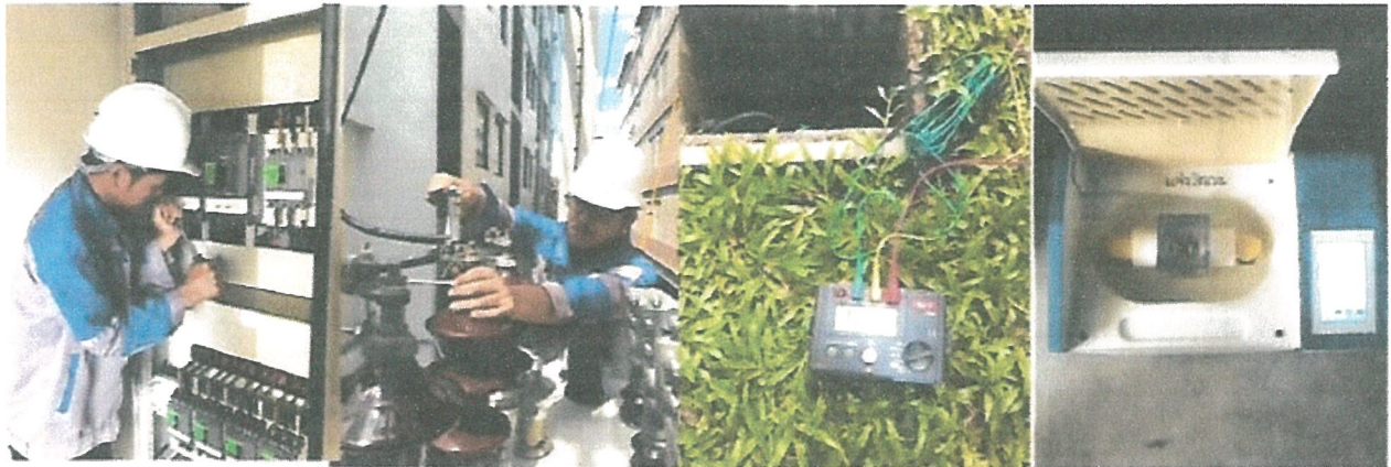
รูปภาพที่ 2.41 การตรวจสอบและบำรุงหม้อแปลงไฟฟ้า
