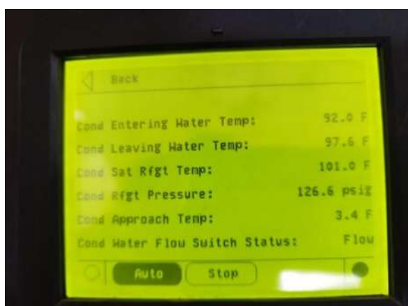
รูปที่ 8 อุณหภูมิใช้งาน และปั๊มน้ำหล่อเย็น(CDP)
