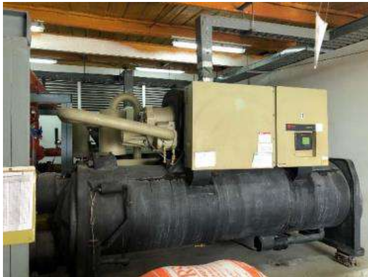
รูปที่ 1 Chiller ที่ใช้ในโรงพยาบาล
