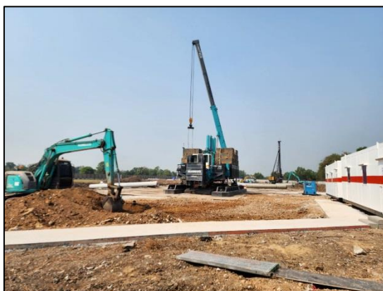
รูปที่ 35 การตอกเสาเข็ม และใช้ผ้ากระสอบหุ้มหัวเสาเข็ม
