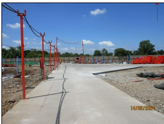
รูปที่ 32 ปูแผ่นเหล็กอย่างหนา และจัดทำถนนคอนกรีตชั่วคราวบริเวณภายในพื้นที่โครงการ
