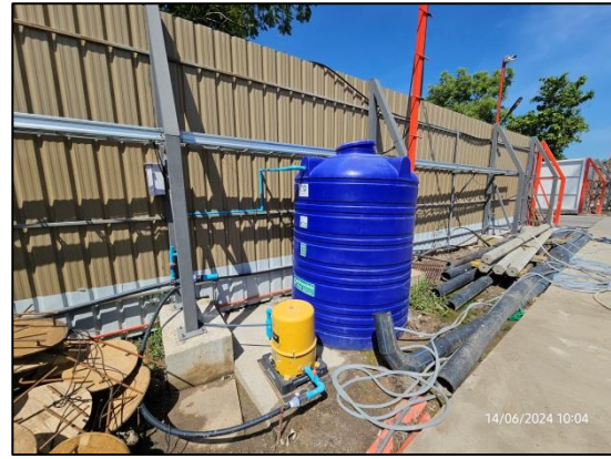
รูปที่ 39 ระบบบำบัดน้ำเสียชนิดเติมอากาศ
