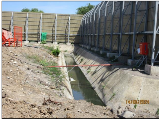
รูปที่ 36 ร่องน้ำ คสล. ความกว้างประมาณ 3 เมตร บริเวณรอบแนวเขตที่ดินด้านทิศเหนือ
