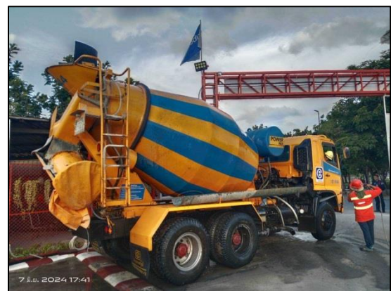
รูปที่ 25 พื้นที่ทำความสะอาดล้อรถบรรทุก และเจ้าหน้าที่ใช้น้ำฉีดล้างล้อก่อนออกจากโครงการ
