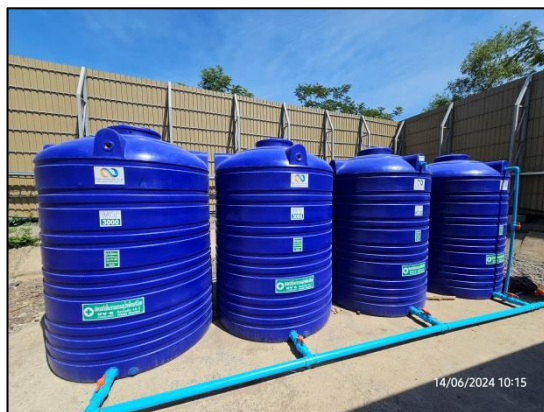
รูปที่ 40 ถังสำรองน้ำใช้อย่างน้อย 25 ลูกบาศก์เมตร/วัน (สำรองน้ำได้อย่างน้อย 1 วัน)
