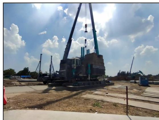
รูปที่ 35 การตอกเสาเข็ม และใช้ผ้ากระสอบหุ้มหัวเสาเข็ม
