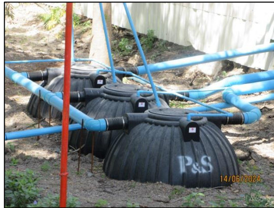
รูปที่ 39 ระบบบำบัดน้ำเสียชนิดเติมอากาศ
