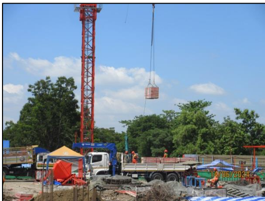
รูปที่ 76 การขนย้ายวัสดุขนาดใหญ่อย่างระมัดระวังเพื่อความปลอดภัยจากการตกลงและไม่ก่อให้เกิดเสียง
