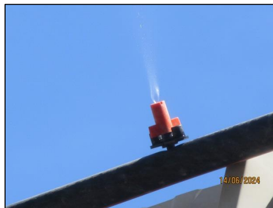
รูปที่ 29 ติดตั้งระบบพ่นละอองสเปรย์น้ำ บริเวณรั้ว Metal Sheet รอบโครงการ
