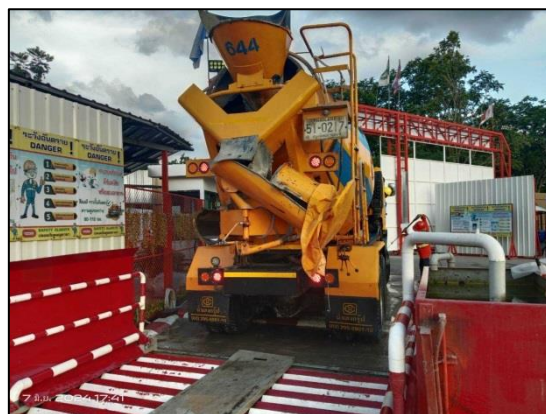
รูปที่ 25 พื้นที่ทำความสะอาดล้อรถบรรทุก และเจ้าหน้าที่ใช้น้ำฉีดล้างล้อก่อนออกจากโครงการ
