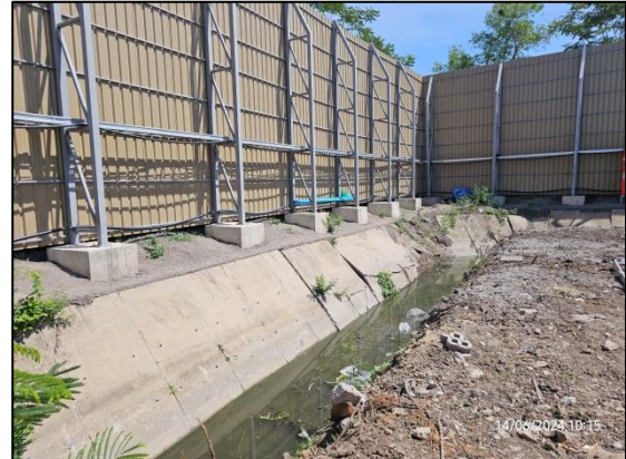
รูปที่ 36 ร่องน้ำ คสล. ความกว้างประมาณ 3 เมตร บริเวณรอบแนวเขตที่ดินด้านทิศเหนือ
