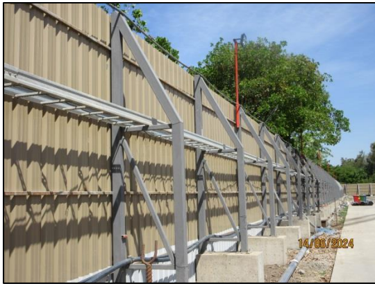
รูปที่ 48 คัดตั้งรางเก็บสายไฟบริเวณโดยรอบโครงการ และไม่ใช่ชุดสายพ่วงต่อพ่วงกันหลายชั้น
