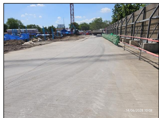
รูปที่ 32 ปูแผ่นเหล็กอย่างหนา และจัดทำถนนคอนกรีตชั่วคราวบริเวณภายในพื้นที่โครงการ
