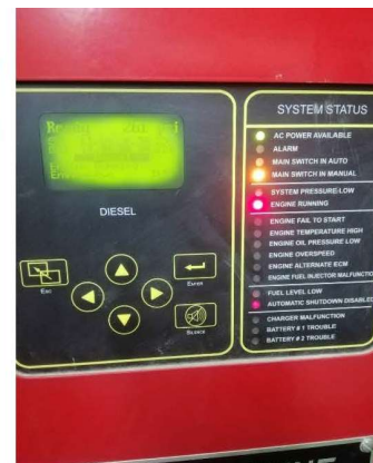
ภาพที่ 4-32 ตรวจสอบระบบไฟฟ้าและไฟฟ้าสำรอง และเครื่องสูบน้ำดับเพลิง
