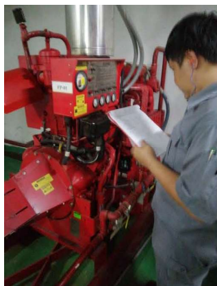
ภาพที่ 4-32 ตรวจสอบระบบไฟฟ้าและไฟฟ้าสำรอง และเครื่องสูบน้ำดับเพลิง
