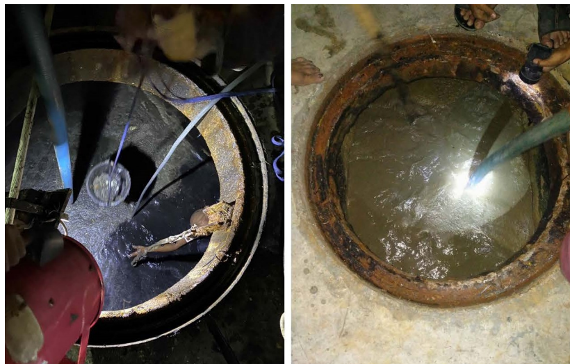
ภาพที่ 4-8 สูดตะกอนออกจากบ่อเกรอะและถึงเก็บตะกอน ดูและระบบบำบัดน้ำเสีย
