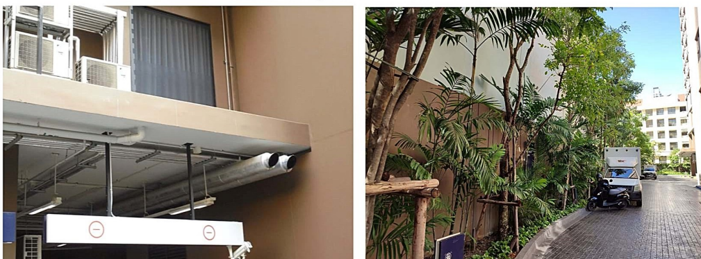
ภาพที่ 3-17 ท่อไอเสียจากห้องไฟฟ้าฉุกเฉิน ปล่องออกมาตรงกับต้นไม้ยืนต้นข้างรั้วโครงการ
