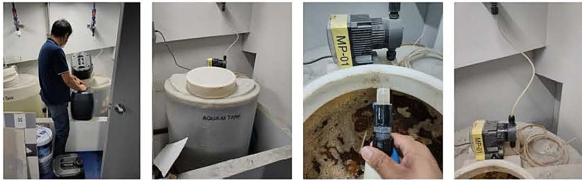
เติมเอนไซม์จำนวน 150 ลิตร ปรับปริมาตรครบ 500 ลิตร ตรวจสอบการทำงานของชุดปั๊มฟีดเอนไซม์ ทำงานได้เป็นปกติ
