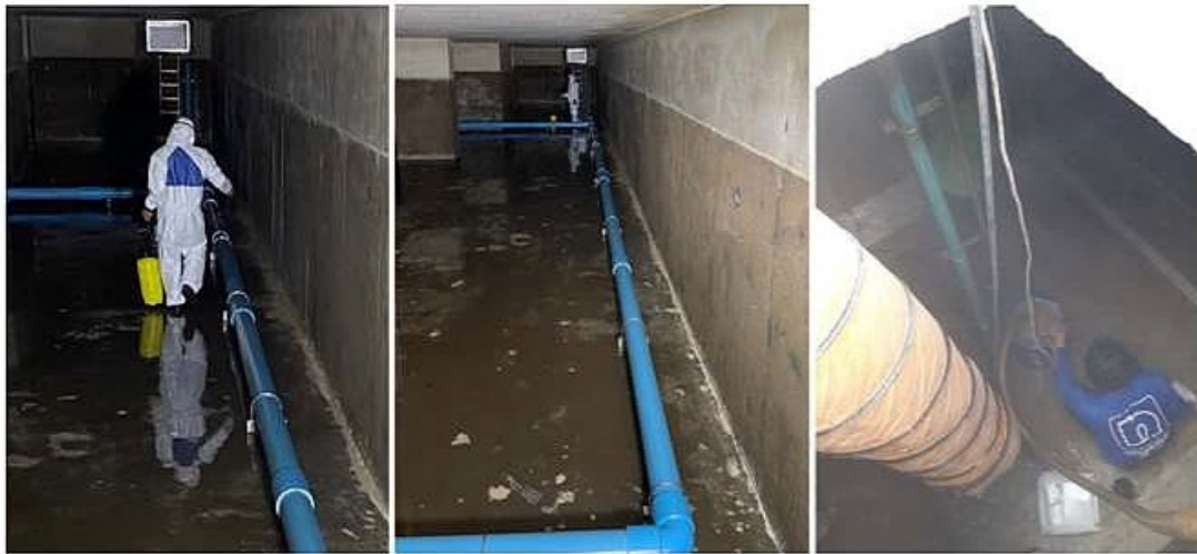
ภาพที่ 3-40 ตรวจสอบดูแลระบบประปา และมอเตอร์สูบน้ำ
