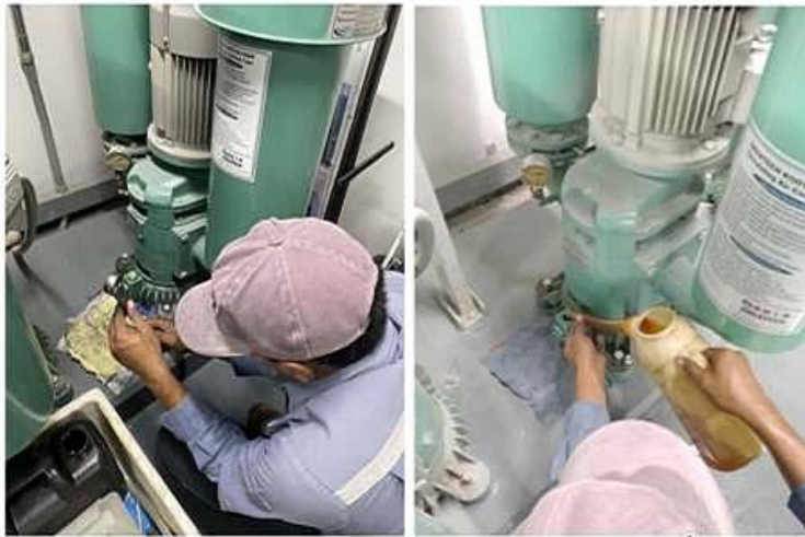
ภาพที่ 3-40 ตรวจสอบดูแลระบบประปา และมอเตอร์สูบน้ำ
