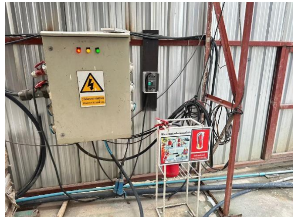
รูปที่ 28 ระบบจ่ายไฟ ป้ายเตือน “อันตรายจากไฟฟ้าช็อต” และ อุปกรณ์ดับเพลิง
