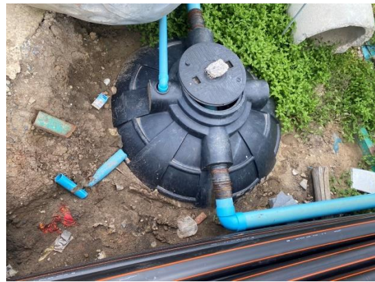
รูปที่ 54 ถังบำบัดน้ำเสียสำเร็จรูป
