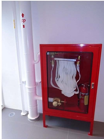
ภาพที่ 3-18 ตู้เก็บสายฉีดน้ำดับเพลิงพร้อมอุปกรณ์
