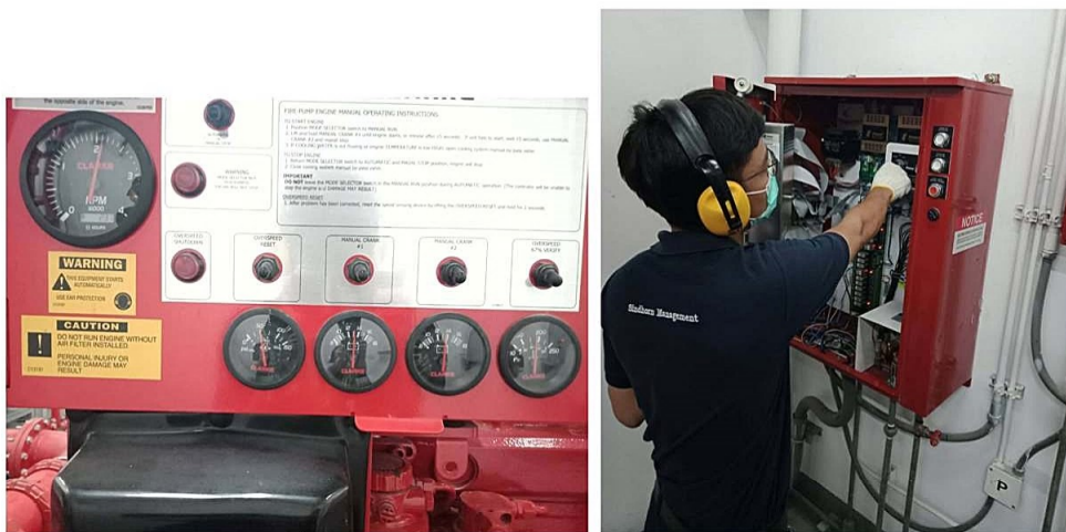
ภาพที่ 3-14 ห้องเครื่องดับเพลิง และการทดสอบประจำสัปดาห์
