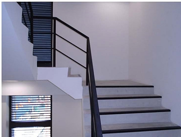
ภาพที่ 3-21 บันไดหนีไฟและช่องเปิดระบายอากาศแบบธรรมชาติ
