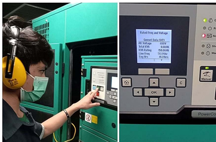
ภาพที่ 3-12 ห้องเครื่องไฟฟ้าฉุกเฉิน บูดด้วยวัสดุกันเสียงและการทดสอบประจำสัปดาห์
