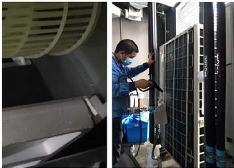
ภาพที่ 3-34 ล้างเครื่องปรับอากาศ ภายในอาคาร
