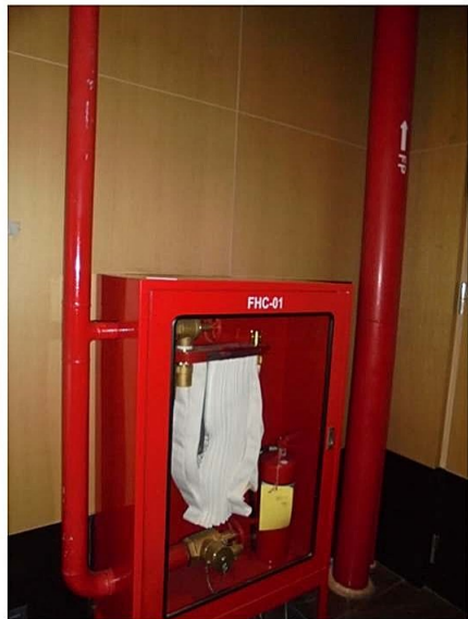
ภาพที่ 3-18 ตู้เก็บสายฉีดน้ำดับเพลิงพร้อมอุปกรณ์
