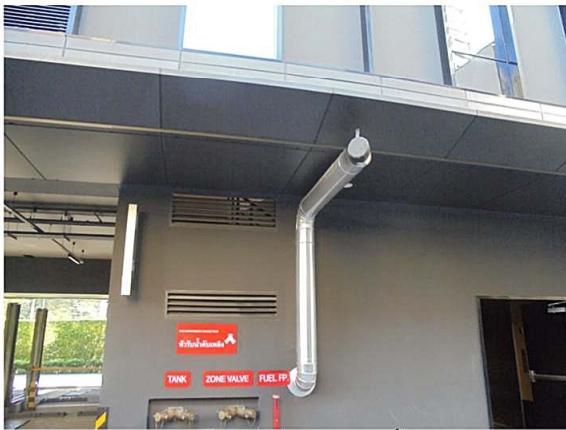
ภาพที่ 3-17 หัวรับน้ำดับเพลิงจากภายนอกโครงการ และไฟฟ้าส่องสว่างฉุกเฉิน
