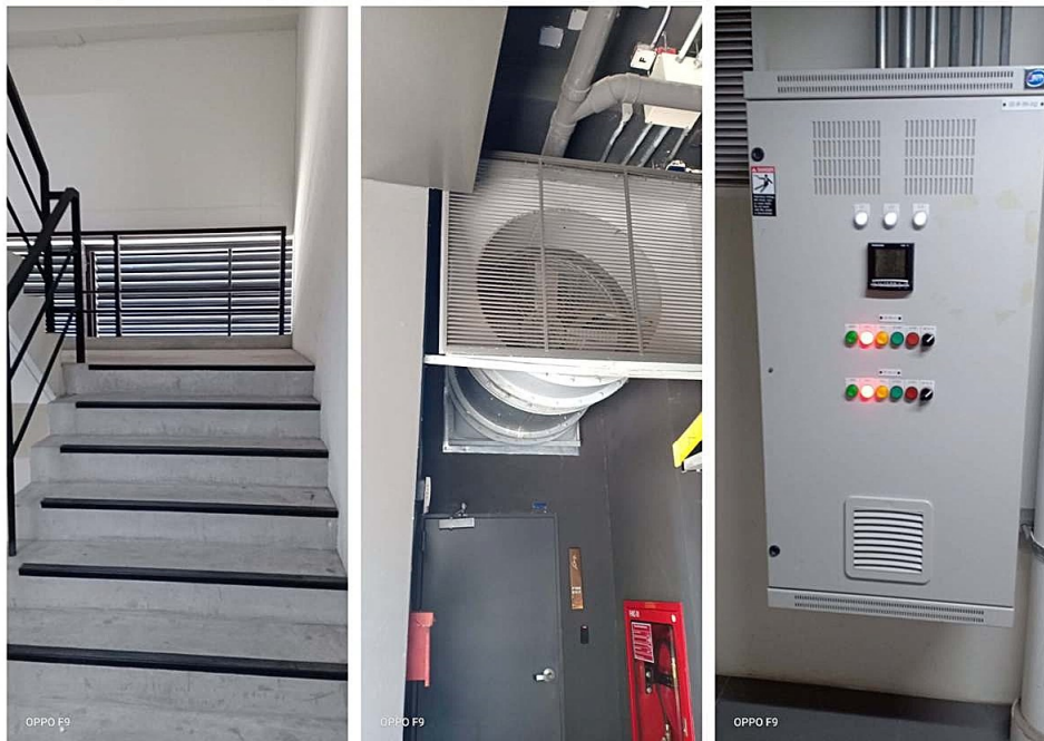
ภาพที่ 2-31 บันไดหนีไฟ และพัดลมระบายอากาศ
