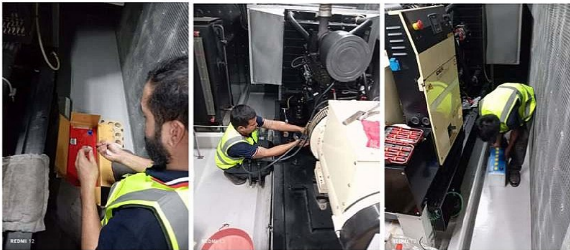
ภาพที่ 2-40 ตรวจสอบและบำรุงรักษา ระบบ Fire Pump และ Generator
