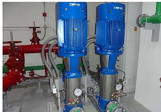
ภาพที่ 2-9 ห้องเครื่องสูบน้ำดับเพลิง และน้ำประปา
