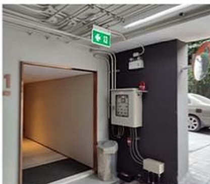
ภาพที่ 2-28 กล้องวงจรปิดและป้ายหนีไฟอาคาร และกระบอกแจ้งบริเวณจุดอัคคีภัย
