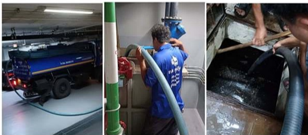
ภาพที่ 2-43 ดูแลรักษาระบบบำบัดน้ำเสีย ดูตะกอนที่บ่อเก็บตะกอน
