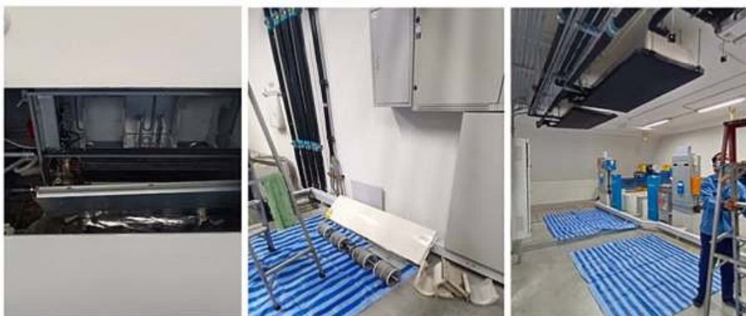
ภาพที่ 2-42 สร้างทำความสะอาดเครื่องปรับอากาศ
