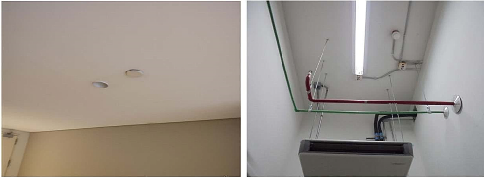
ภาพที่ 2-19 หัวกระจายน้ำอัตโนมัติและเครื่องตรวจจับควัน
