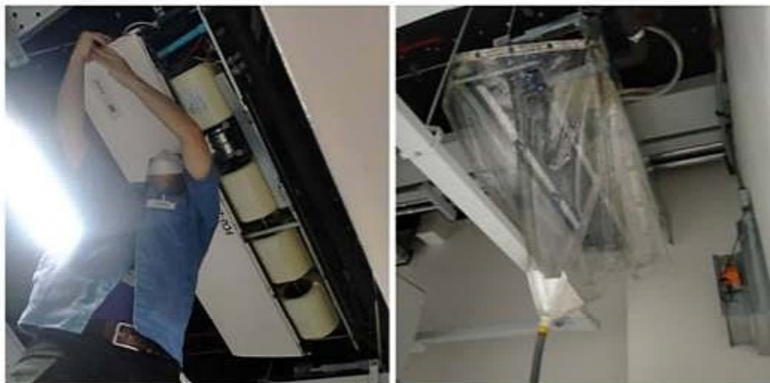
ภาพที่ 3-42 ล้างเครื่องปรับอากาศภายในอาคาร
