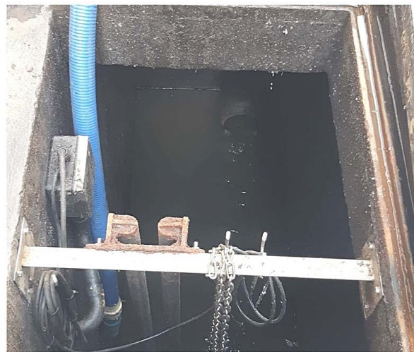
ภาพที่ 3-37 สูบตะกอนในระบบบำบัดน้ำเสีย
