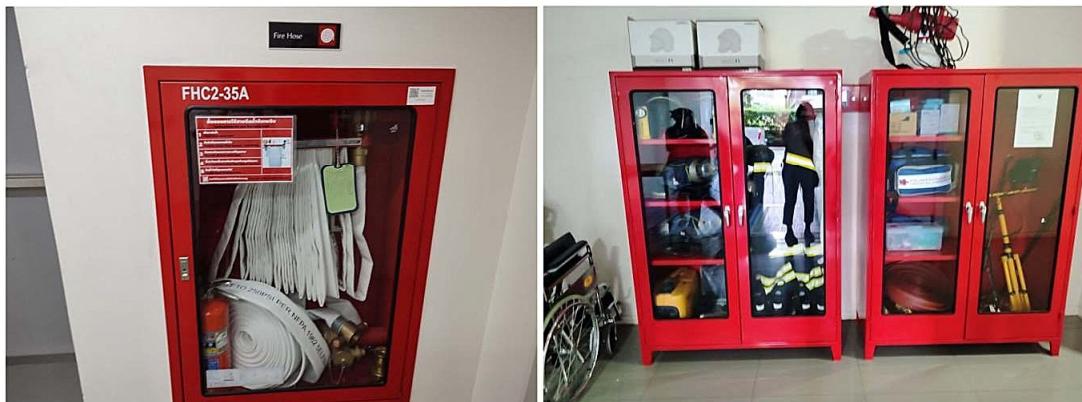
ภาพที่ 3-19 ตู้เก็บสายฉีดน้ำดับเพลิงและอุปกรณ์
