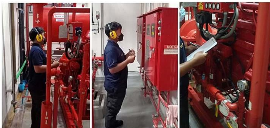
ภาพที่ 3-17 ห้องเครื่องสูบน้ำดับเพลิง และการตรวจสอบระบบ Fire Pump
