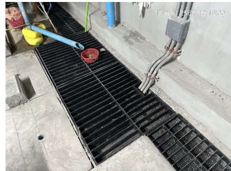
ภาพที่ 2.2-10 รางระบายน้ำ และบ่อพักน้ำภายในพื้นที่โครงการ
