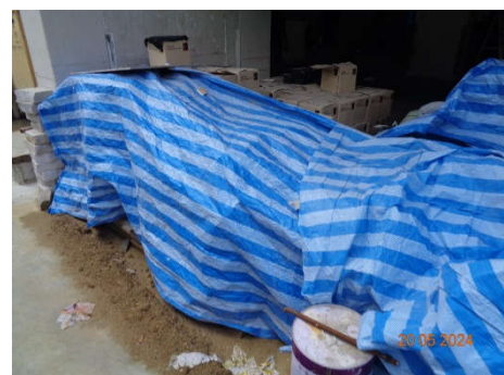
ภาพที่ 2.2-13 การปิดคลุมกองวัสดุก่อสร้าง
