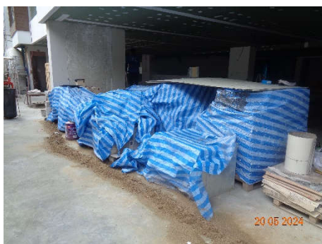
ภาพที่ 2.2-13 การปิดคลุมกองวัสดุก่อสร้าง
