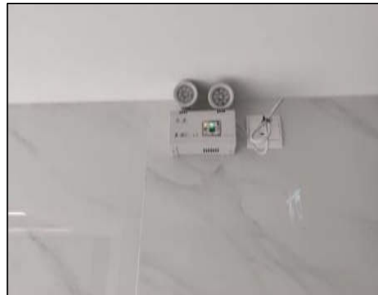
รูปที่ 2-32 ไฟฉุกเฉิน (Emergency Light)
