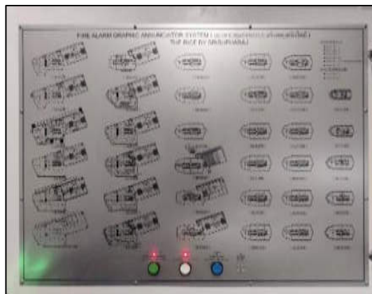
รูปที่ 2-20 แผงควบคุมระบบแจ้งเหตุอัคคีภัย (Fire Alarm Control Panel)
