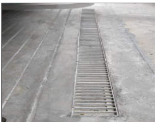
รูปที่ 2-12 รางระบายน้ำ และตะแกรงดักขยะ
