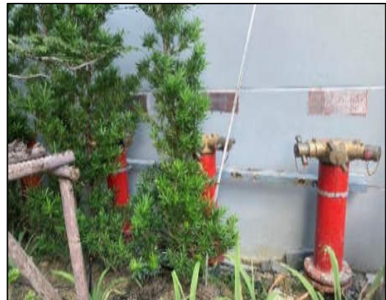
รูปที่ 2-26 หัวรับน้ำดับเพลิง (Fire Department Connection)
