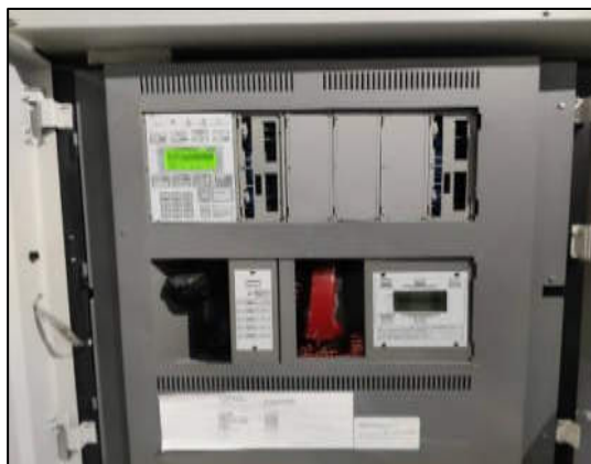
รูปที่ 2-20 แผงควบคุมระบบแจ้งเหตุอัคคีภัย (Fire Alarm Control Panel)
