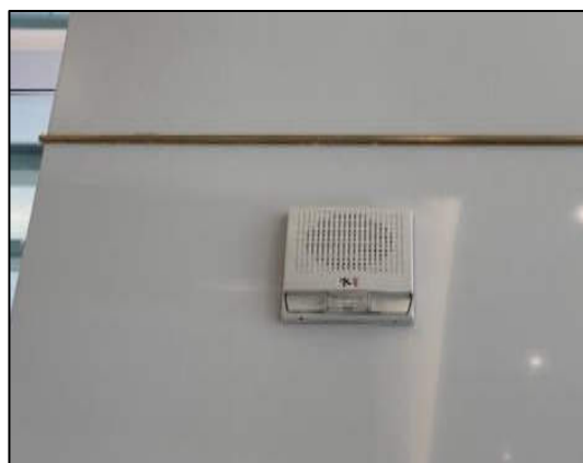
รูปที่ 2-24 สัญญาณแจ้งเหตุแบบกริ่ง (Alarm Bell)
