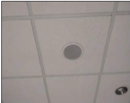
รูปที่ 2-25 ลำโพงติดเพดาน (Ceiling Speaker)
