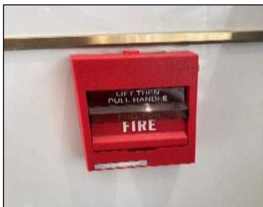
รูปที่ 2-23 อุปกรณ์แจ้งเหตุด้วยมือ (Manual Pull Station)
