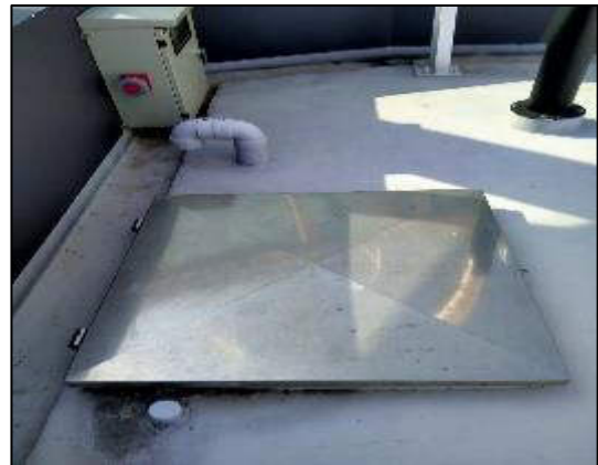
รูปที่ 2-9 ถังสำรองน้ำใช้ชั้นดาดฟ้า
