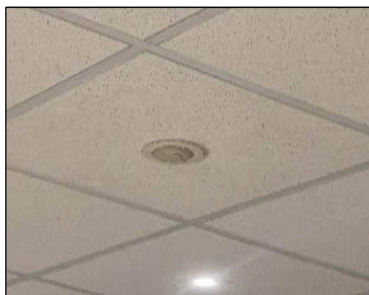
รูปที่ 2-22 เครื่องตรวจจับความร้อน (Heat Detector)
